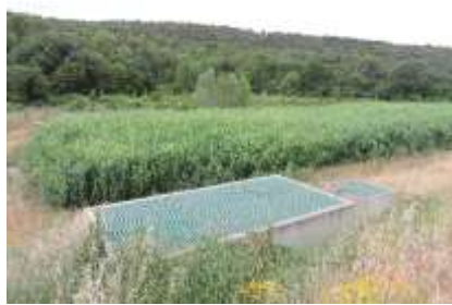
Station d'épuration à filtres plantés de roseaux de la Bastide des Jourdans
