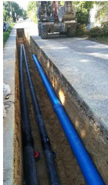
Pose de conduites d'eau potable et d'assainissement
