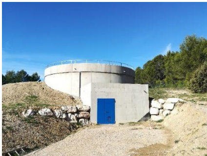
Nouveau réservoir quartier Archimbaude
