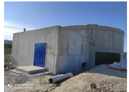
Station de pompage de Boiry
